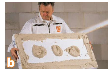
Klejenie płyt izolacyjnych zaprawą quick-mix RKS metodą obwiedniowo-punktową lub całopowierzchniową (na grzebleniach)
