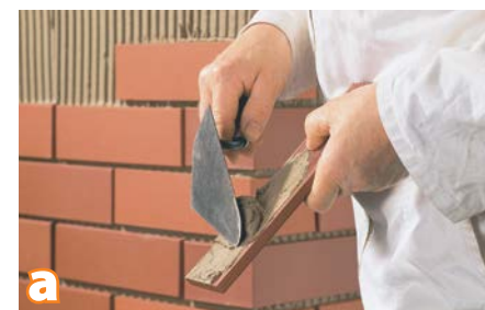
Po pełnym stwardnieniu warstwy zbrojącej (przerwa technologiczna co najmniej 7 dni) można mocować okładziny ceramiczne. Płytki należy kleić metodą tzw. kombinowaną (floating – buttering). Na stwardniałą warstwę zbrojącą nanosić za pomocą pacy zębatej (zęby 8 x 8 mm lub 10 x 10 x 10 mm) warstwę zaprawy klejowej ok. 3-4 mm. Na stronę odwrotną płytki nanosi się kryjącą warstwę zaprawy klejowej o grubości ok. 1 mm
