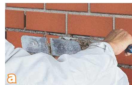
Spoinowanie zaleca się rozpocząć po upływie ok. 14 dni od przyklejenia płytek. Zaprawę do fugowania quick-mix FMT lub RFS o konsystencji „mokrej ziemi” starannie wciskać w spoiny za pomocą kielni fugówki. Minimalna głębokość spoiny to 8 mm a wysokość to 6 mm
