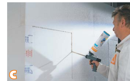
Otwarte szczeliny między płytami zaleca się wypełnić przy pomocy niskoprężnej piany montażowej lub materiałem izolacyjnym
