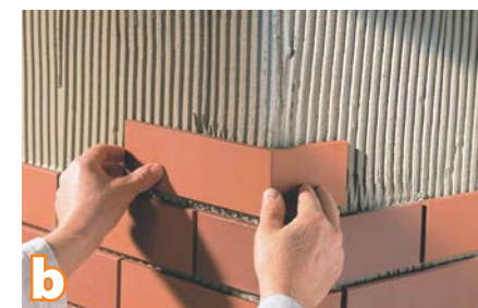
Klejenie płytek klinkierowych powinniśmy rozpocząć od narożników budynku. Warto stosować płytki systemowe narożne, dzięki temu uzyskamy estetyczną i trwałą fasadę
