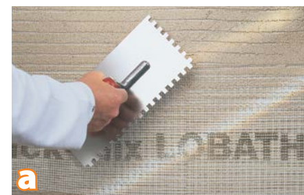
Pełnopoверхniowe zatapianie siatki zbrojącej QMS 160 w zaprawie szpachlowej quick-mix RAS na grubość warstwy min. 5 mm
