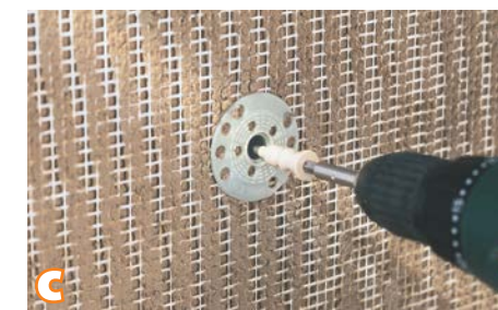
Talerzyk łącznika po docięnięciu powinien zostać zatopiony w świeżej zaprawie. Bezpośrednio po osadzeniu łączników należy nałożyć drugą warstwę zaprawy RAS (świeżej na świeżej) na łączną grubość warstwy zbrojącej 7-10 mm
