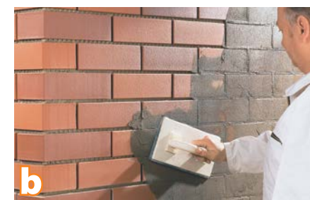
Spoinowanie fugą RSS możemy rozpocząć po 7 dniach od przyklejenia płytek. Zaprawę do spoinowania quick-mix RSS o konsystencji szlamu nanosić diagonalnie do przebiegu fug za pomocą pacy z twardą gumową listwą lub zbierakiem gumowym. Zaprawę starannie wprasowywać w fugi między płytkami. Nadmiar zaprawy usunąć za pomocą pacy z gumową listwą. Po wstępnym przeschnięciu zaprawy, powierzchnię płytek zmyć kilkakrotnie za pomocą wilgotnej gąbki (quick-mix RSS stosować wyłącznie do płytek szklawionych nienasiąkliwych o gładkiej strukturze)
