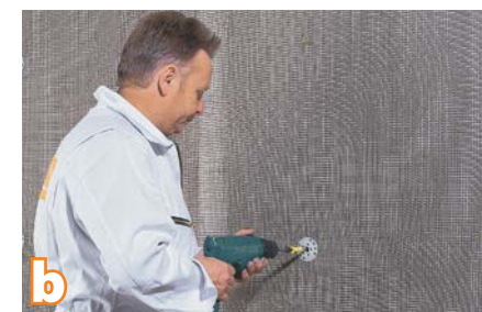
Montaż łączników mechanicznych z trzpieniem metalowym odbywa się po zatopieniu siatki zbrojącej w warstwie zaprawy RAS . Osadzanie łączników należy wykonać w czasie kiedy zaprawa nie jest całkowicie wyschnięta i utwardzona
