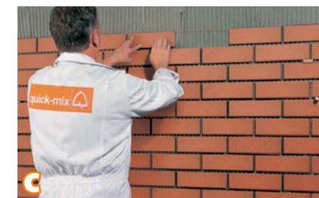
Następnie płytki mocno docisnąć do powierzchni zaprawy, zwrócić przy tym uwagę, aby nie powstały pustki i wolne przestrzenie. Po ułożeniu okładziny grubość zaprawy musi wynosić przynajmniej 3 mm. Po wstępny stwardnieniu fugi należy wydrapać i oczyścić na odpowiednią głębokość (przynajmniej na grubość płytek okładzinowych)
