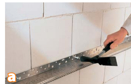
Przed przyklejeniem płyt izolacyjnych, należy zamocować profil startowy
