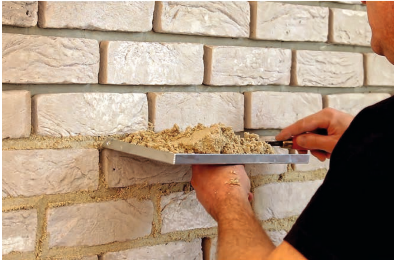
Fot. 2. Wypełnianie przestrzeni między okładzinami za pomocą spoinówki
